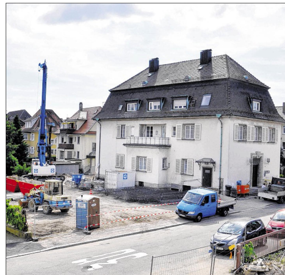
EIN NEUES ÄRZTEHAUS entsteht neben dem ehemaligen Reichsbankgebäude in der Gartenstraße 15. Offizieller erster Spatenstich ist am 21. Juni. Foto: Margull
