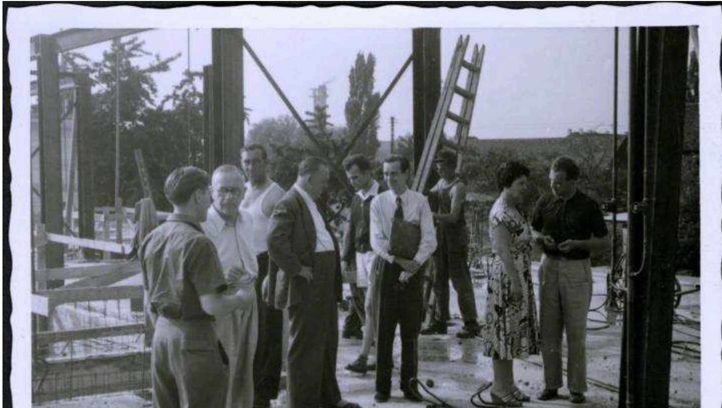
Baustellenbegehung beim Richtfest des Eiermann-Baus. Ganz rechts im Bild Bauleiter Hans Schmidberger, der Auftraggeberin Aenne Burda über den Stand der Bauarbeiten informiert
